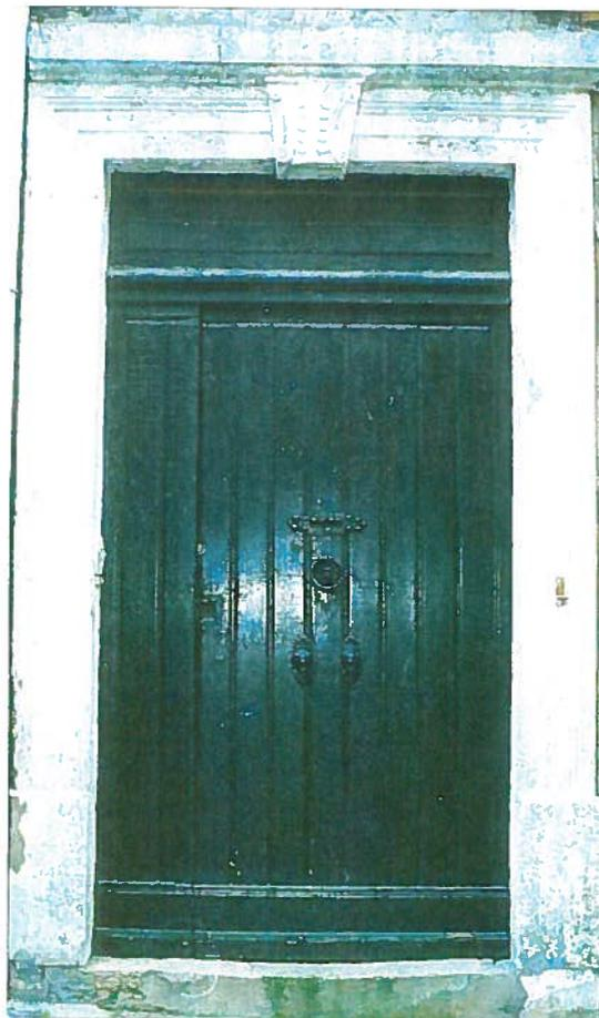
*Exemple de répartition entre partie fixe et partie ouvrante dans un ensemble homogène*
